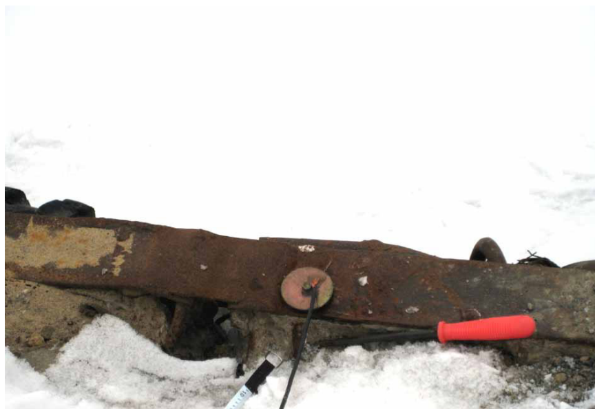
Рис. 1. Присоединение провода к оголовку железобетонной сваи
